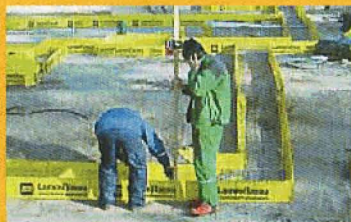
Valmisraketised paigaldatakse tasandatud ja tihendatud pinnasele.
