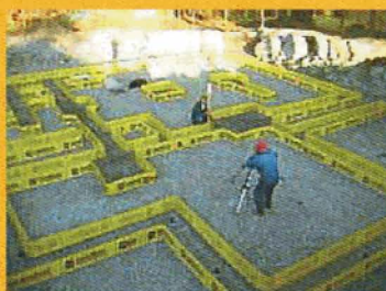
Valmisraketiste abil on ka keeruka noone alusmüür võimalik valada ja valmis teha ühe päevaga.
