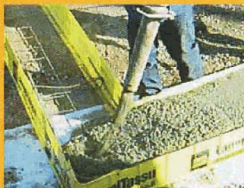
Pärast võimaliku lisamaterjali paigaldamist valatakse raketis betooni tšis ja pind tasandatakse vajalikul kõrgusel.
