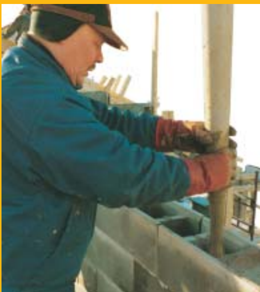
Sein valatakse kuni kolme meetri kõrguste osadena. Betoonivalu klass määratakse kindlaks ehitusprojekti.
