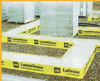
Kui betoon on kivistunud, ei ole raketist vaja ära võtta. Nii ei kogune kuniide tarbetut ehitusprahi.
