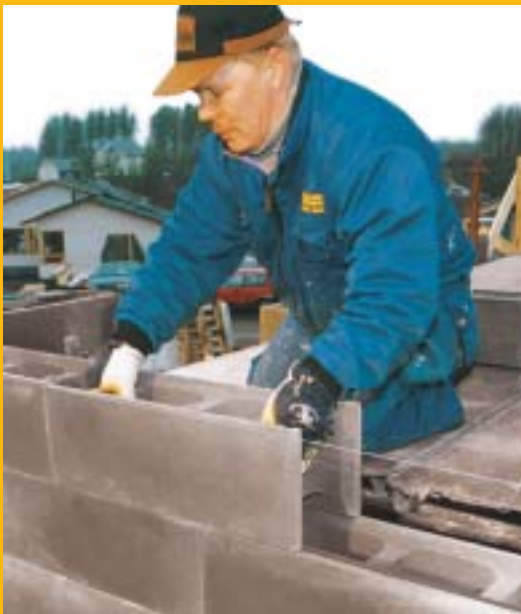
Plokkide ülaserv on teemantlihvimise abil möödus. Nii on lihtne laduda ka kõrgeid konstruktsioone.
