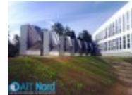
Lennuakadeemia - suurima õhk-vesi soojuspumba katlamajaga Eestis
